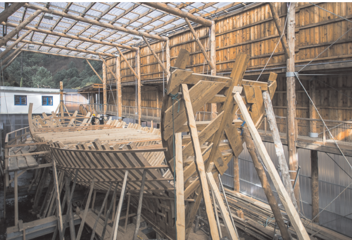
San Juan baleontziaren erreplika zehatzaren eraikuntzaren ikuspegi bat Vista de la construcción de la réplica exacta de la nao San Juan
